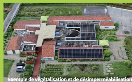
Exemple de végétalisation et de désimperméabilisation
